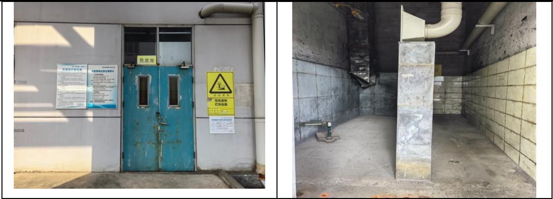
图 4-1 现有 1 号危废库照片
